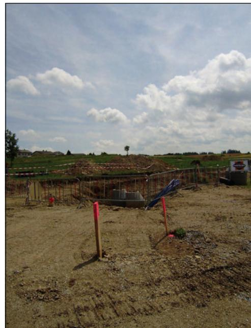
Bei den neuen Bauplätzen wird derzeit der Kanal, die Wasserleitung sowie der EVN Anschluss, die Straßenbeleuchtung und der Straßenunterbau vorgenommen. Somit sind die Parzellen für Bauwerber ab Herbst dieses Jahres komplett abgeschlossen verfügbar.
